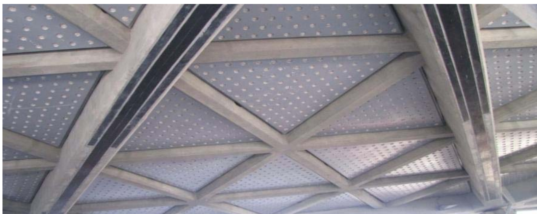
در مرحله بعد دو عدد تسمه کربنی CFRP Laminate بصورت سراسری در میان دو نوار اولیه نصب شده اند.
