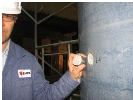
عکس «۱۲»: نتیجه یکی از تستهای pull off
