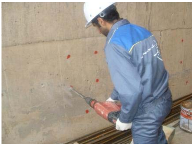
سوراخ کاری و تمیز کردن سوراخ ها پیش از کاشت
