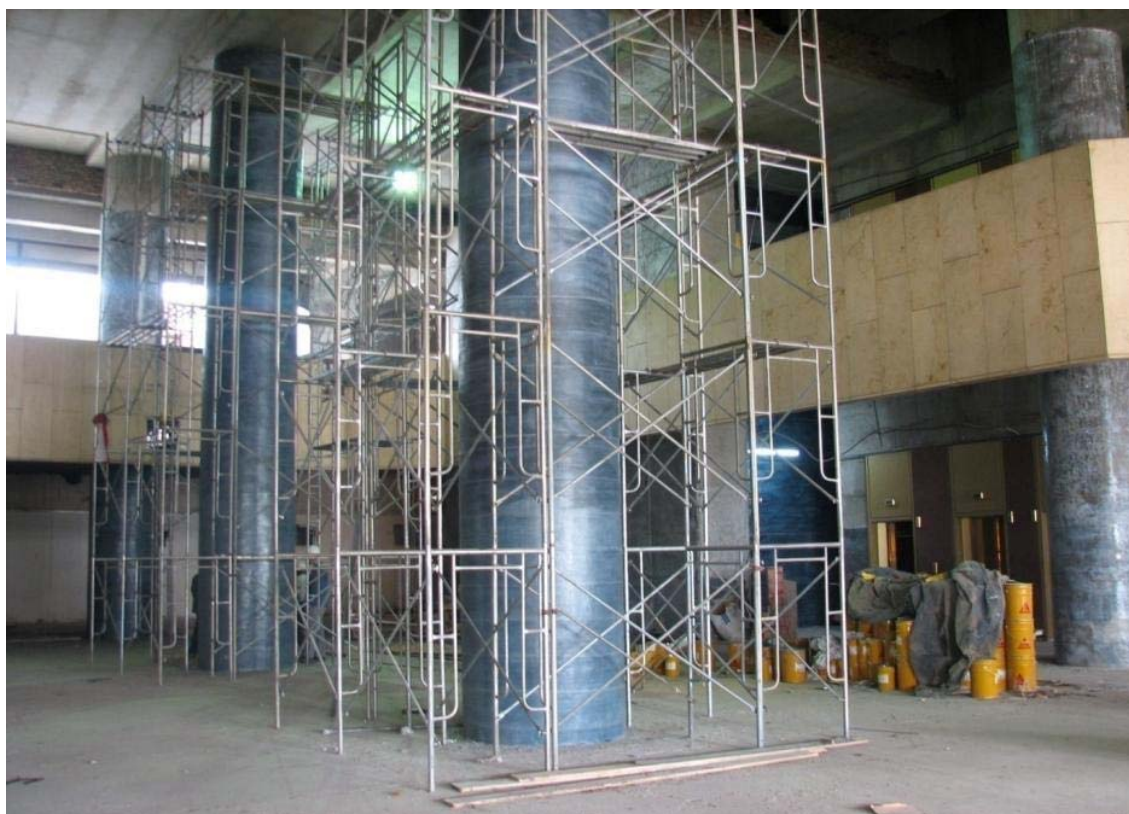
لابی هتل آزادی بعد از تقویت سازه ای: ستونهای میانی به ارتفاع 10.50 m توسط لایه های CFRP تقویت شده اند.
