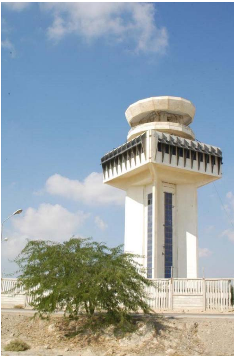
برج مراقبت فرودگاه قشم پس از وقوع زلزله ۵ ریشتری
