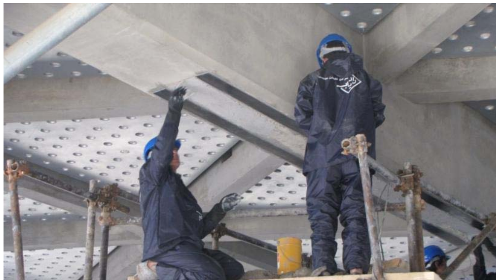
ابتدا دو عدد تسمه کربنی CFRP Laminate به طول مورد نظر در محل خاص خود نصب شده اند.
