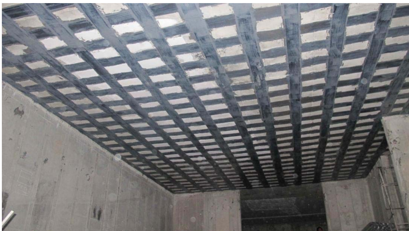
در عکس فوق یکی از دال های تقویت شده توسط نوارهای FRP مشاهده می شود.
