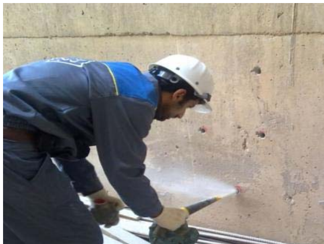
سوراخ کاری و تمیز کردن سوراخ ها پیش از کاشت
