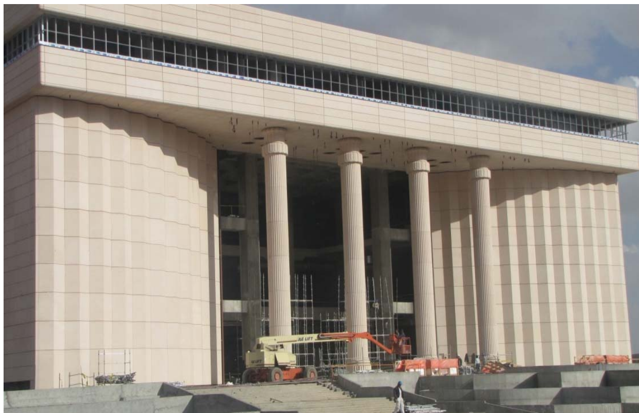
نمای ورودی اصلی ساختمان مرکز تجاری خلیج فارس و محل نصب نمای شیشه ای با ابعاد بسیار بزرگ.
