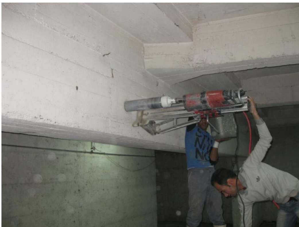
نمونه گیری از بتن تیر جهت انجام آزمایش مقاومت فشاری بتن
