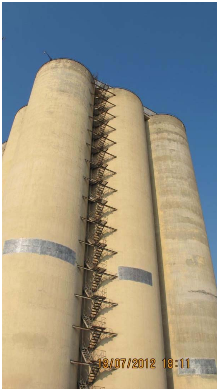
سیلوهای بتنی گندم پس از ترمیم ترک ها توسط الیاف FRP
