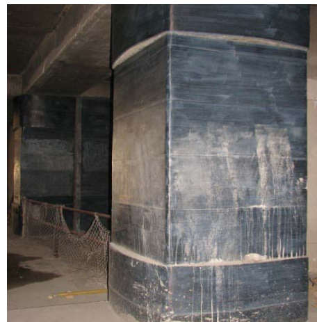
عکس های شماره «۹» و «۱۰»: تغییر مقطع ستون مربع در بالا و پائین در منطقه فشاری (Reprofiling)
