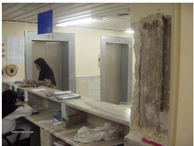
انجام تست های مخرب و غیر مخرب به موازات کارکرد روزانه بیمارستان بدون تداخل در امور جاری.
