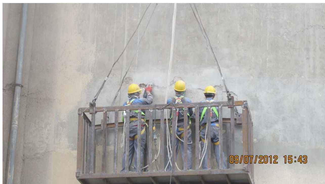
در عکس فوق نحوه سائیدن (Grinding) سطح بتن و زیر سازی قبل از نصب FRP دیده میشود.
