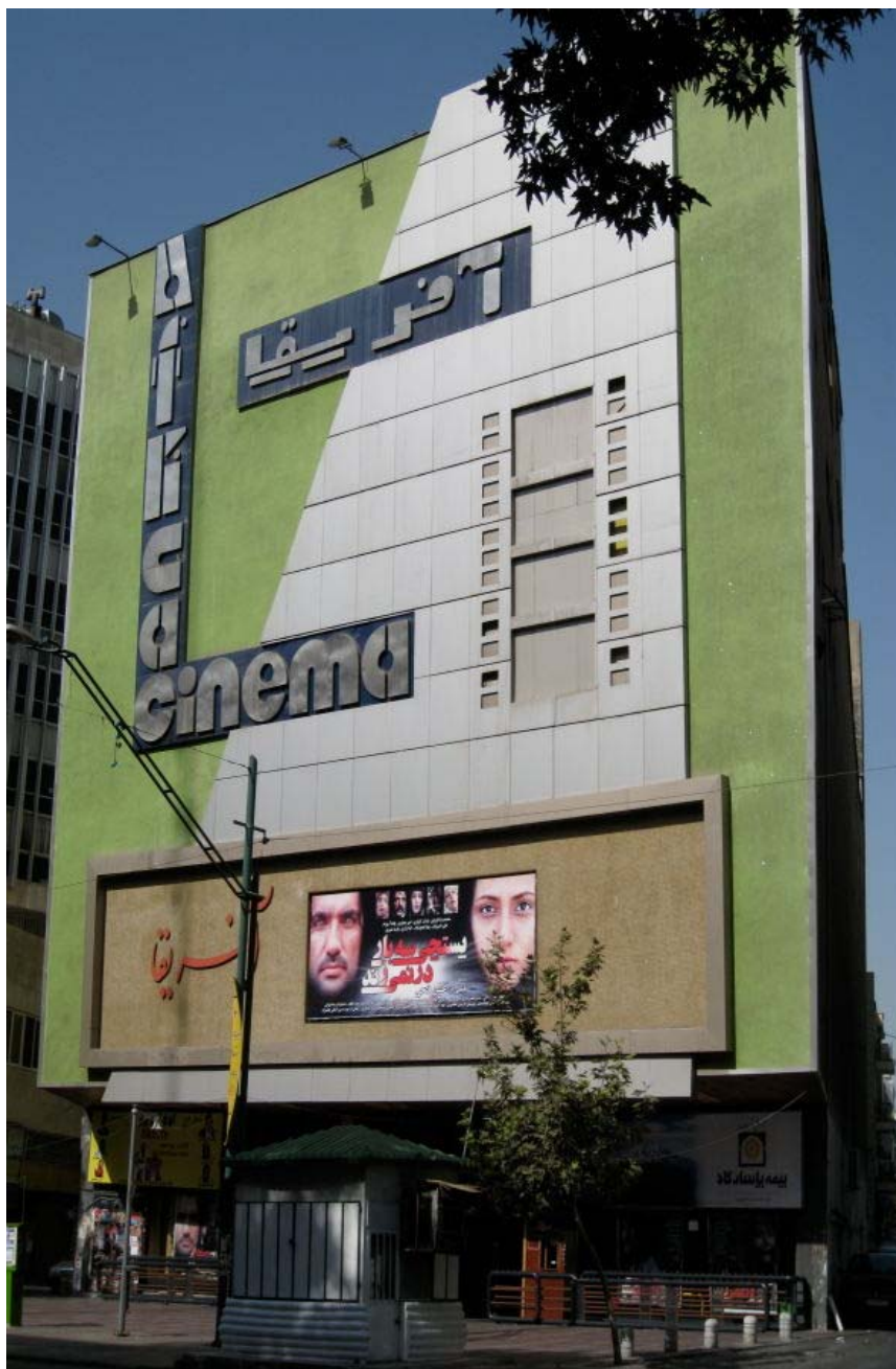
ساختمان سینما آفریقا واقع در خیابان ولیعصر
