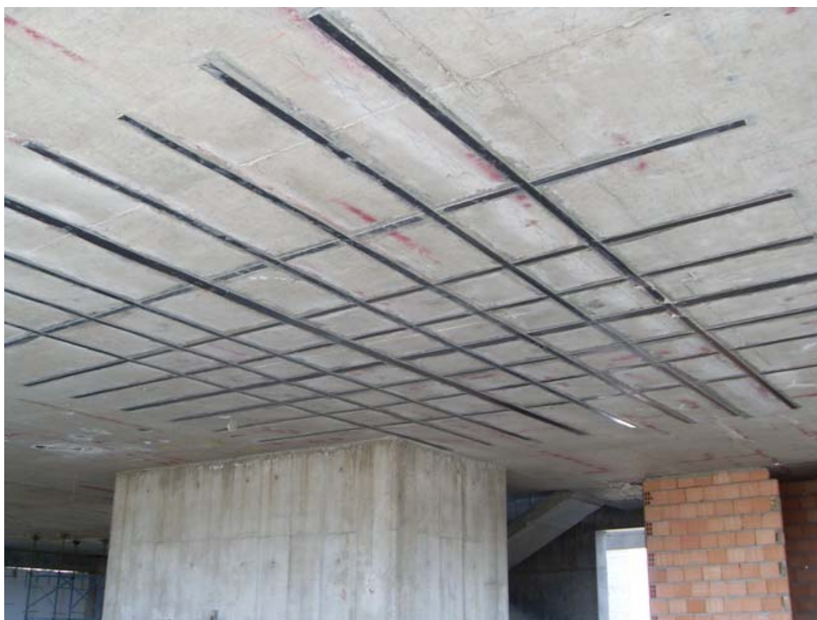
در عکس فوق دال تقویت شده پروژه مسکونی اشرفی اصفهانی توسط نوارهای FRP قابل مشاهده می باشد.
