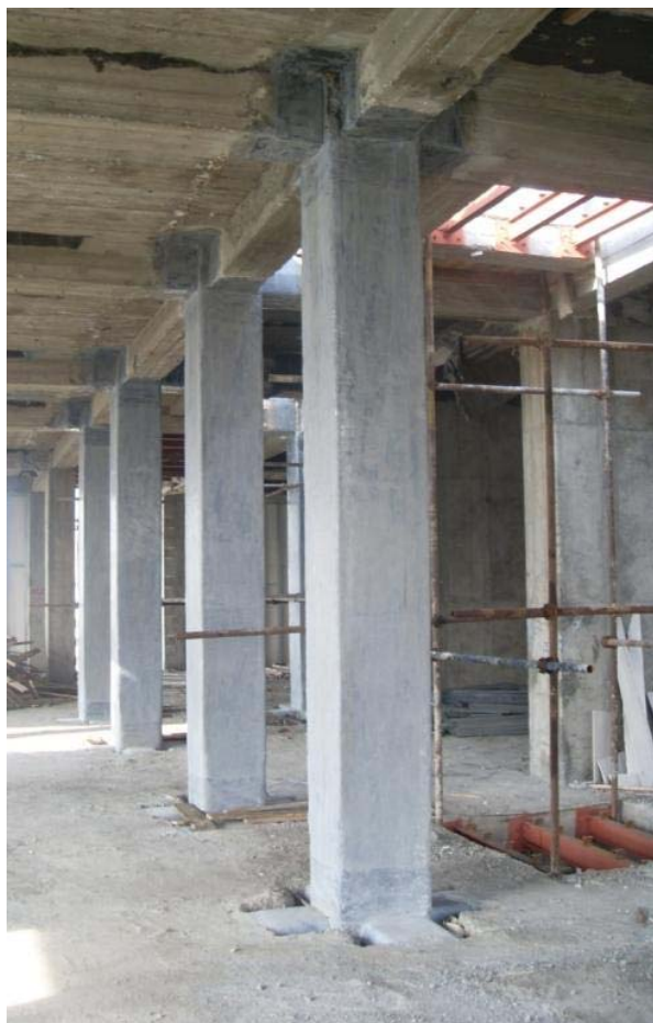
عکسهای فوق نشان دهنده تقویت خمشی ستونها توسط الیاف FRP و مهار شیتها با امتداد آنها روی تیر و دورپیچ کردن می باشد.
