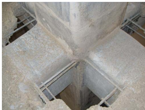
همانطور که در عکسهای فوق مشاهده می شود جهت دورپیچ شیتهای FRP امتداد داده شده از روی ستون حفره هایی در کف طبقه ایجاد شده است تا شیتها به طور کامل دور تیرها پیچیده شوند.
