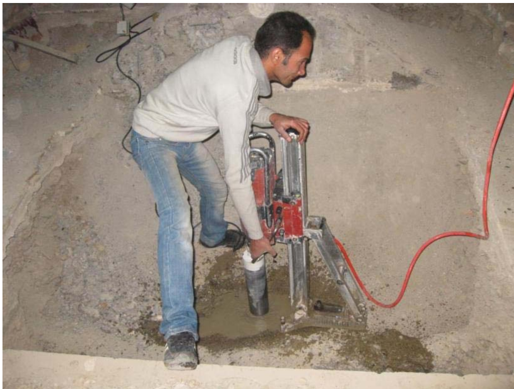
نمونه گیری از بتن فونداسیون جهت انجام آزمایش مقاومت فشاری بتن
