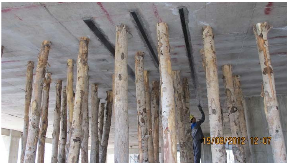
در عکس فوق چگونگی نصب نوارهای FRP در زیر دال مشاهده می شود.
