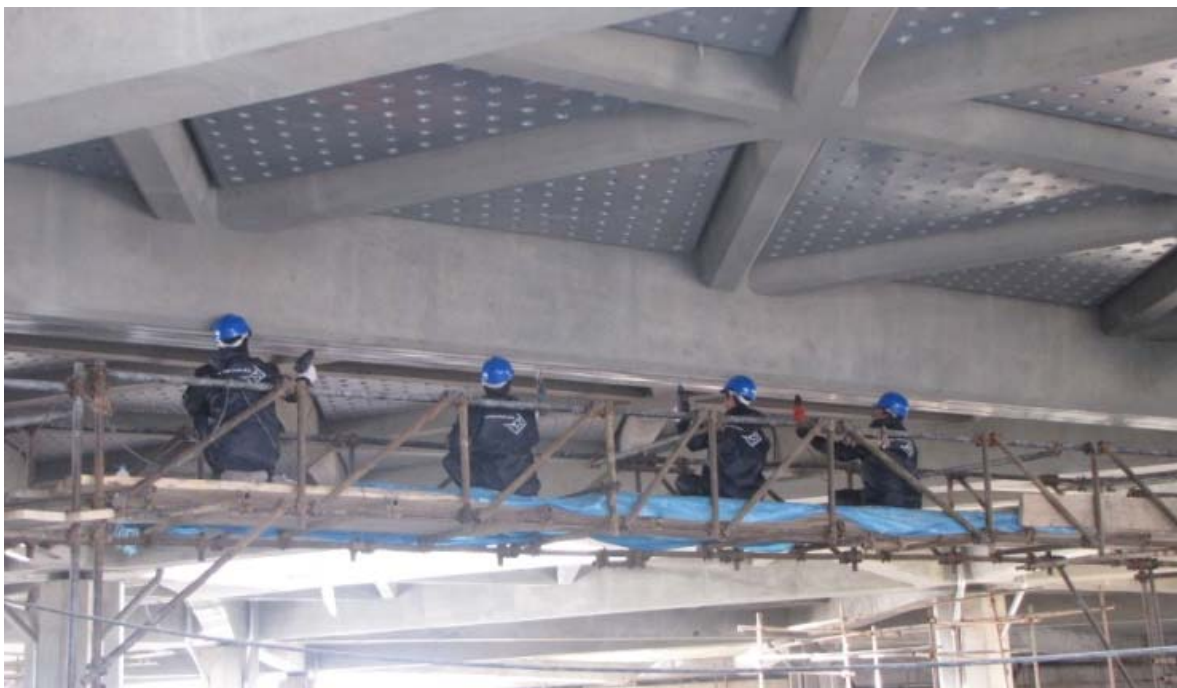
در عکس فوق دو عدد نوار کربنی بصورت CFRP Laminates در زیر تیر بصورت موضعی نصب شده اند.
