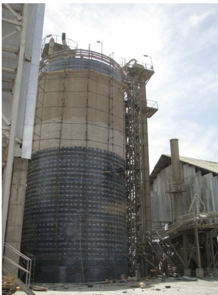
در عکس فوق نحوه تقویت سیلوی بتنی با استفاده از ورقه های کربنی CFRP در بالا و پایین سیلو مشاهده میگردد.
