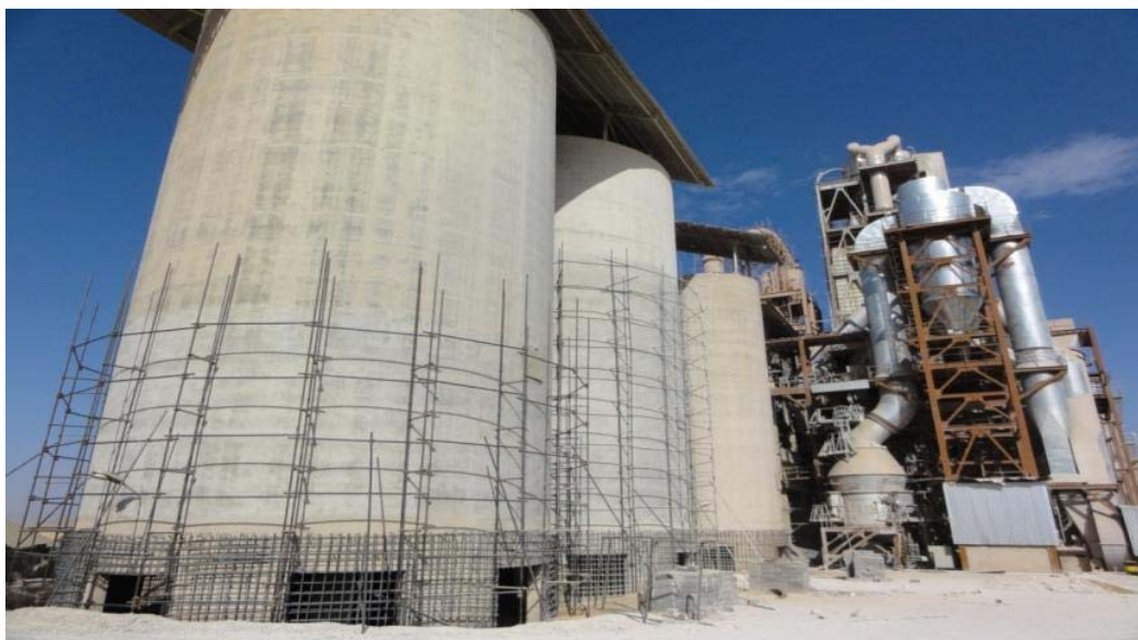
در عکس فوق عملیات زیرسازی سیلوها قبل از نصب FRP مشاهده میشود.
