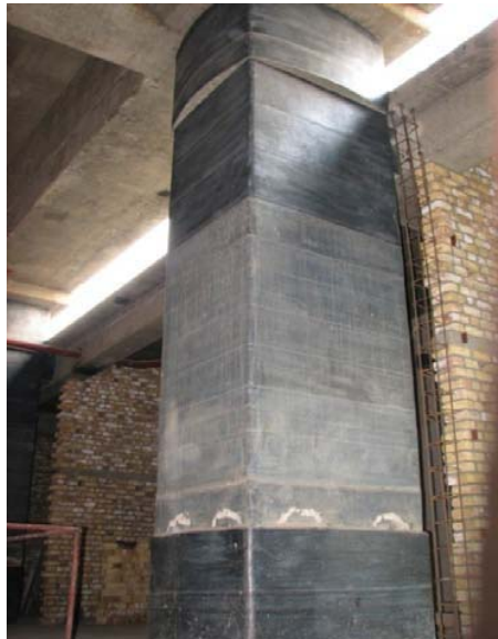
عکس های شماره «۹» و «۱۰»: تغییر مقطع ستون مربع در بالا و پائین در منطقه فشاری (Reprofiling)
