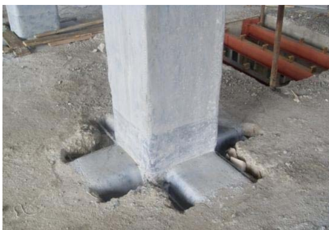
همانطور که در عکسهای فوق مشاهده می شود جهت دورپیچ شیتهای FRP امتداد داده شده از روی ستون حفره هایی در کف طبقه ایجاد شده است تا شیتها به طور کامل دور تیرها پیچیده شوند.
