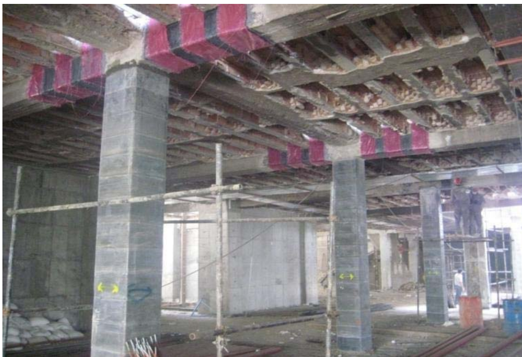
تیرهای بتنی پس از تقویت برشی با FRP
