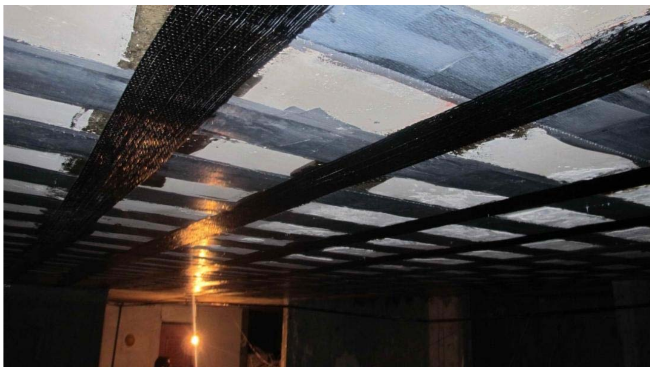
در عکس فوق نحوه اتصال الیاف FRP به سقف قابل مشاهده می باشد.
