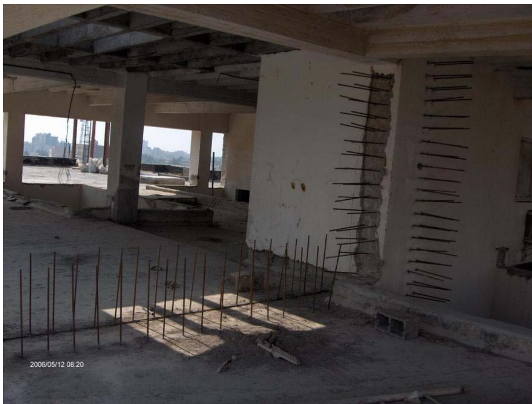
سوراخکاری و کاشت میلگرد در کف و دیوار بتنی برای احداث دیوار برشی جدید در سازه.
