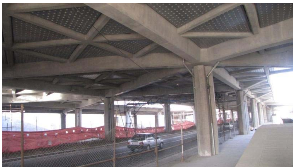
در پایان محل نصب نوارهای کربنی در زیر تیرها توسط مواد هم رنگ بتن پوشیده شده است.
