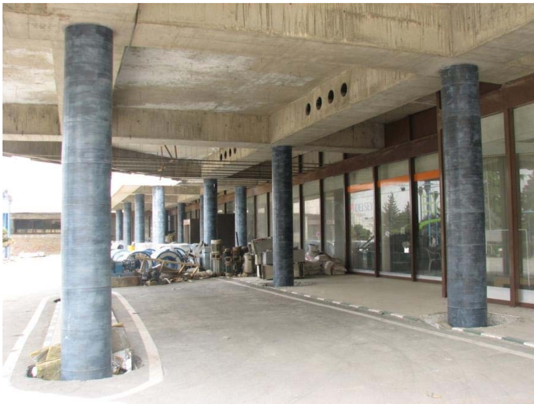
تقویت ستونهای خارجی هتل بزرگ آزادی تهران توسط لایه های CFRP
