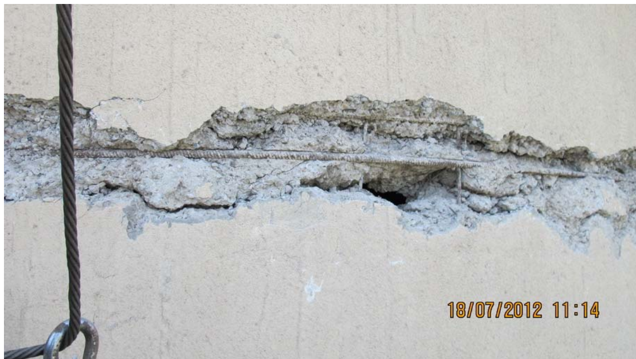
یک نمونه از ترکهای موجود در سیلوهای بتنی
